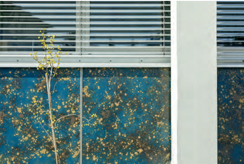
Die Fassade des Rathauses in Prinzersdorf aus Keramik – ein Unikat in Blau-Gelb – blieb erhalten, die undichten Fenster wurden erneuert.
